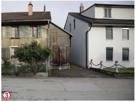
Rue du Petit Bâle 7,9
