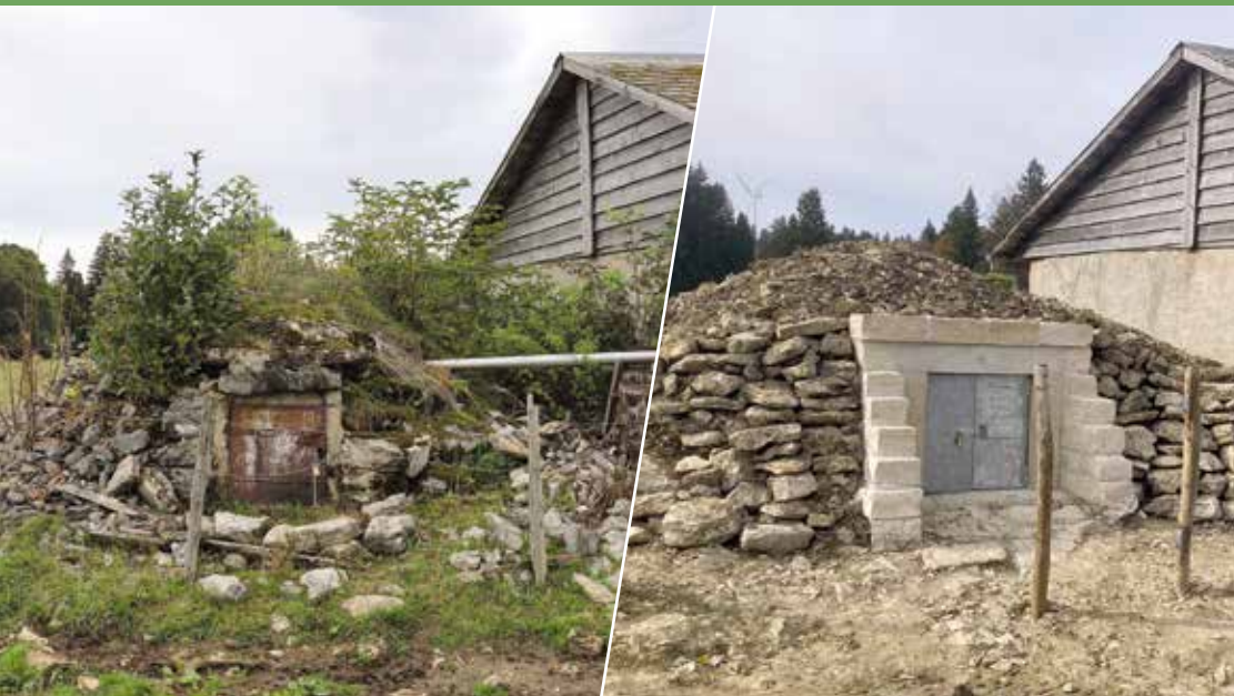
La citerne située au lieu-dit Sur les Roches, avant et après les travaux.
