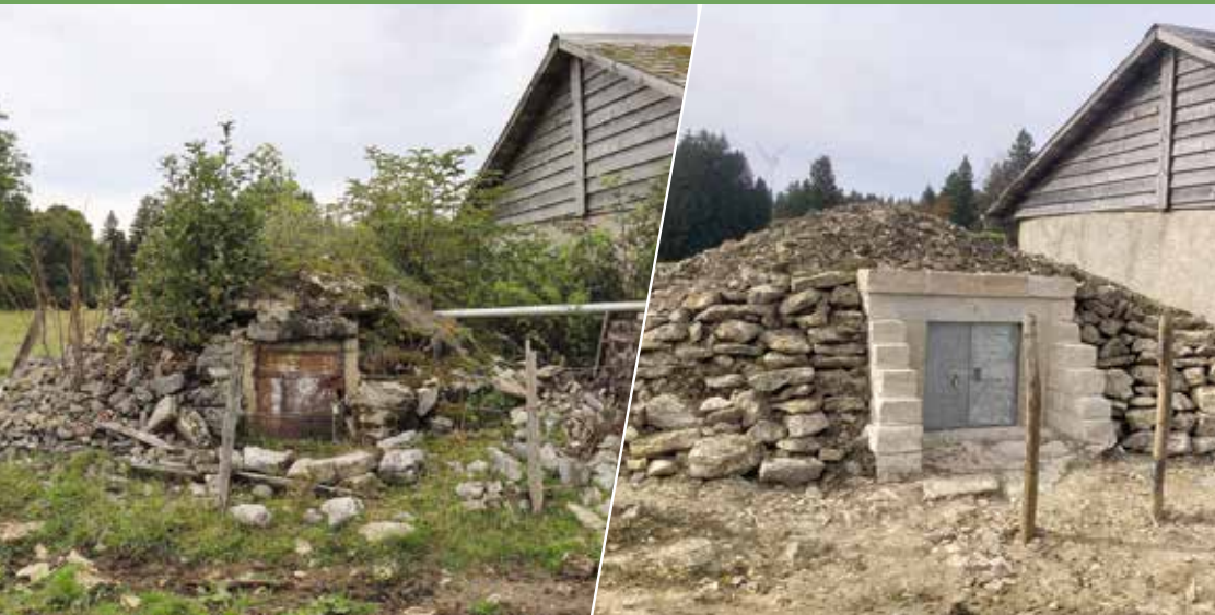
Die Zisterne in der Flur Sur les Roches – vor und nach den Instandsetzungsarbeiten.
